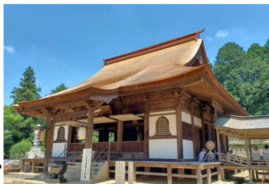
屋根大改修後の本堂(令和4年)
