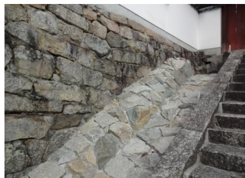
補強工事完成 (上・写真2枚)
