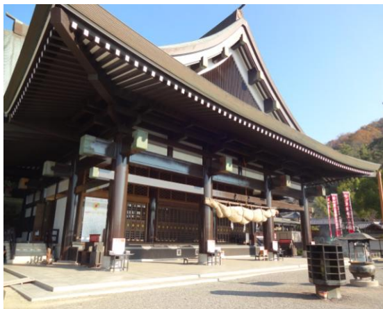
最上稲荷本殿(靈光殿) 昭和54年完成
